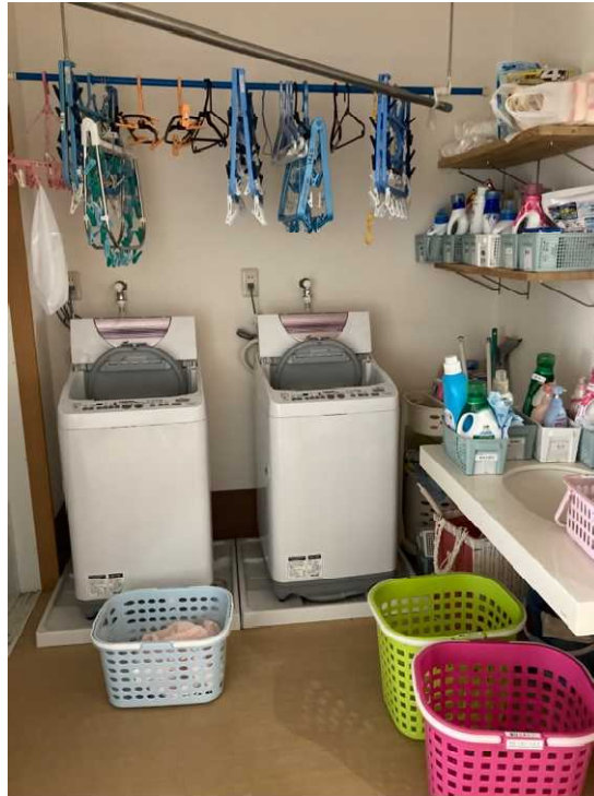
写真5 「高齢者向け介護施設におけるランドリー」
