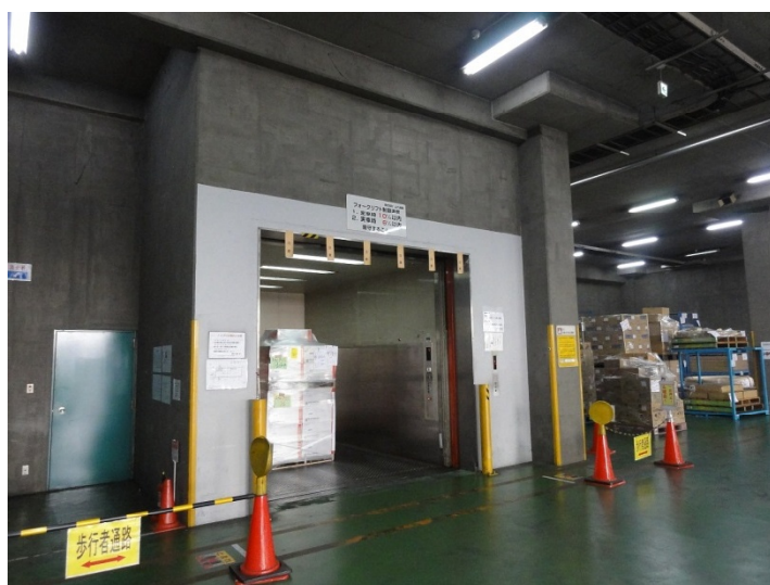
(エレベーターからフォークリフトが出てきたときにそこを横切る者との接触危険への対策です。)
