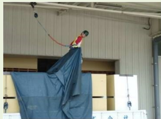
写真③ 安全帯取り付け設備
