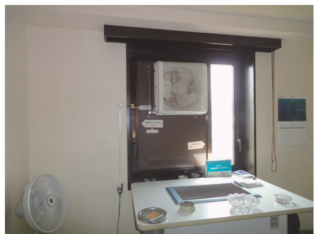
回転窓に換気扇を設置
